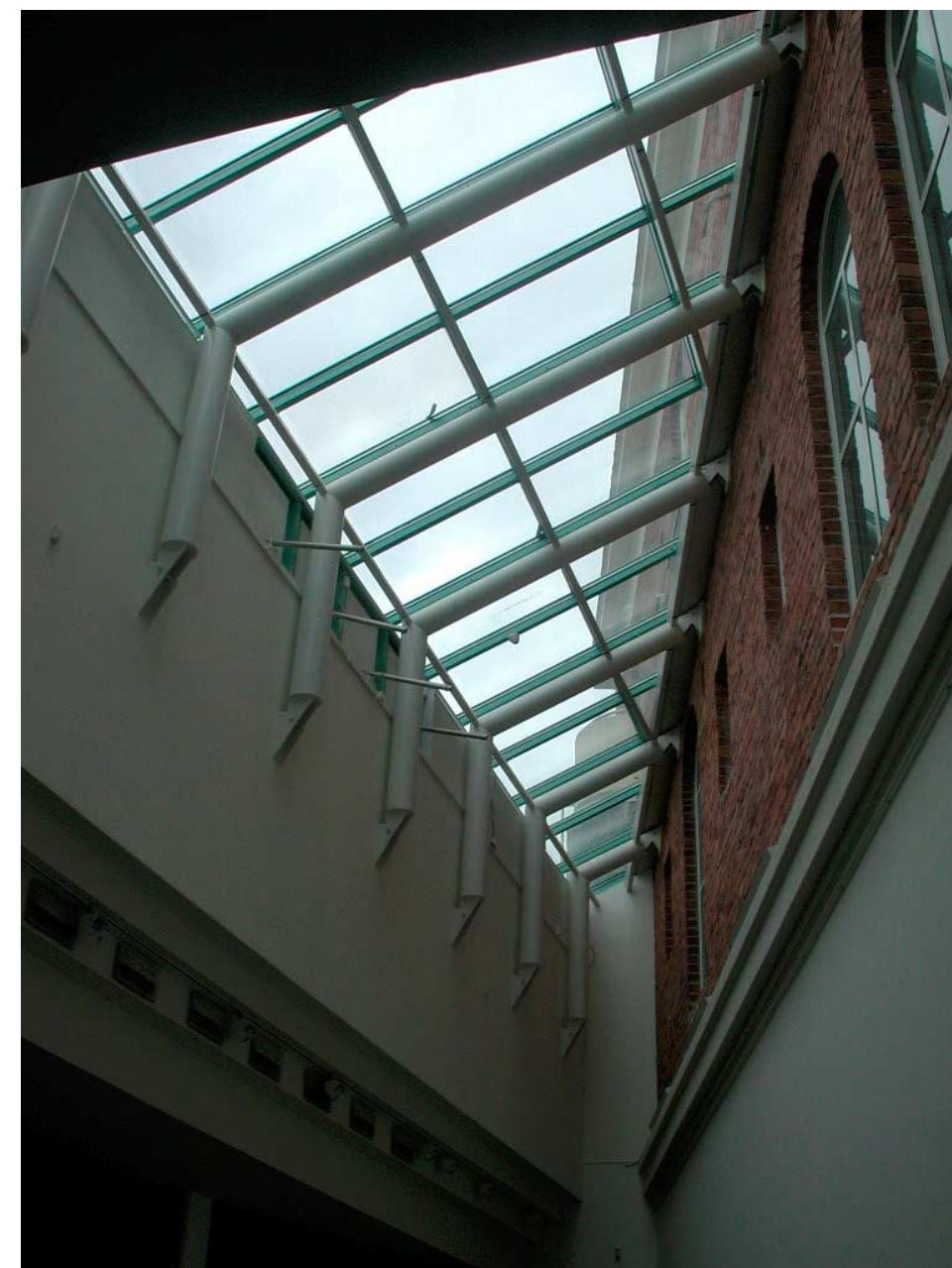
Vanhan ja uuden rakennusosan liittymän lasikatto
